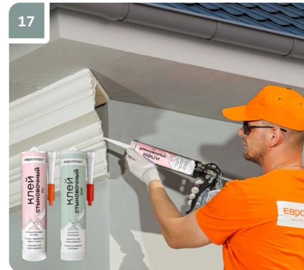
17 Нанести клей «Европласт Стыковочный» на торец уже смонтированного изделия.
