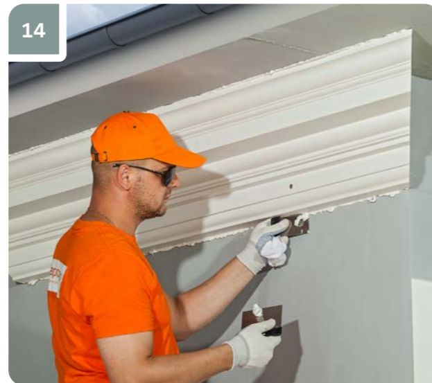
14 Сразу после фиксации саморезами удалить излишки клея шпателем.
