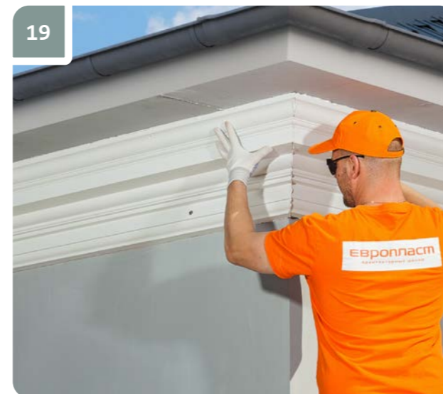
19 Приложить изделие к месту установки. Прижать по всей длине, чтобы клей выступил из-под всей плоскости примыкания. Смещая изделие вдоль стены, прижать к соседнему изделию, чтобы клей выступил на стыке.
