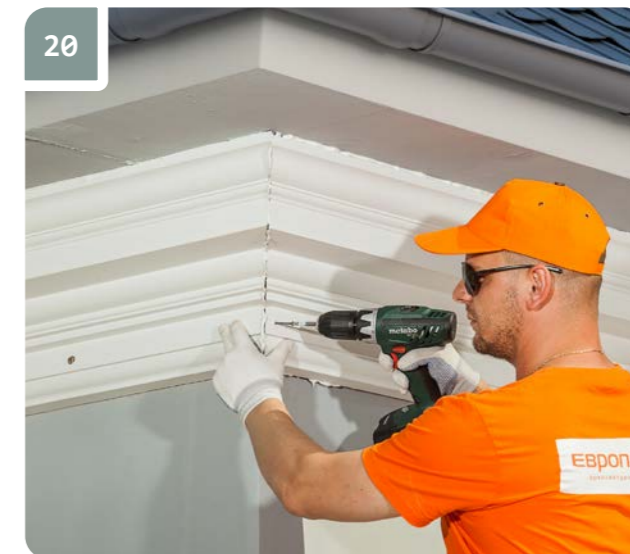
20 Зафиксировать стык при помощи саморезов.
