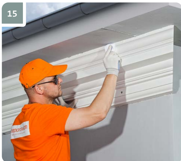
15 При необходимости места примыкания изделия к поверхности протереть ветошью, смоченной ацетоном.
