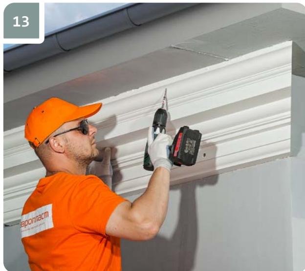
13 При помощи шуруповерта и самореза притянуть верхнюю часть изделия, углубив шляпку самореза в изделие на 2 мм.
