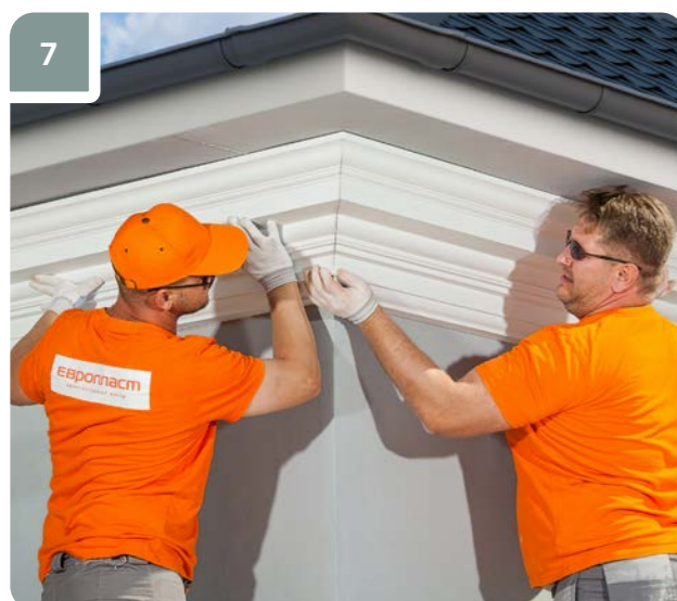
7 Проверить совмещение рисунка и профиля изделий.
