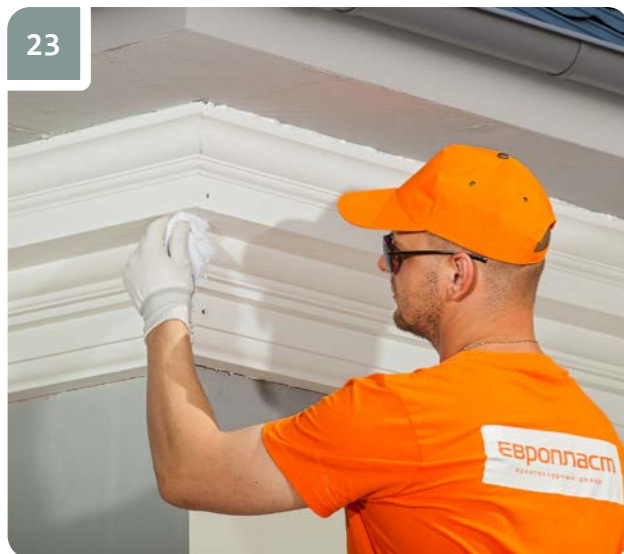
Протереть стык ветошью, смоченной ацетоном.
