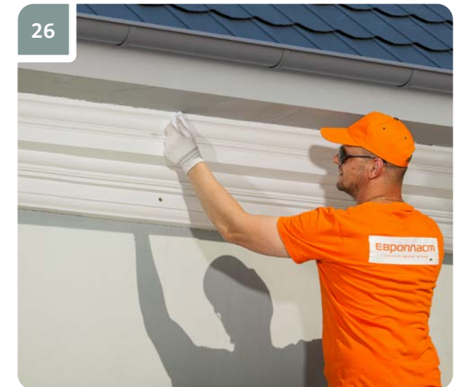
Удалить излишки клея ветошью, смоченной ацетоном.
