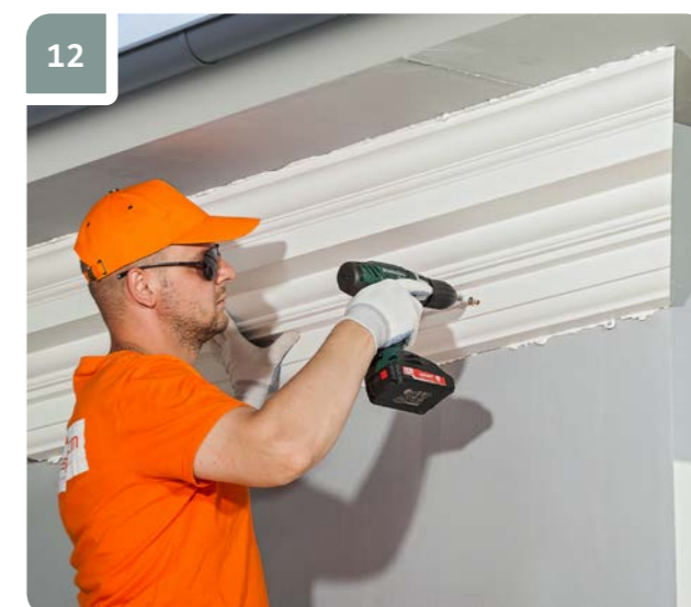
12 При помощи шуруповерта углубить шляпку дюбель-гвоздя в изделие на 2 мм.
