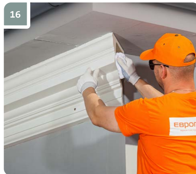
16 Увлажненной ацетоном ветошью очистить от пыли и других загрязнений торцы стыкуемых изделий.
