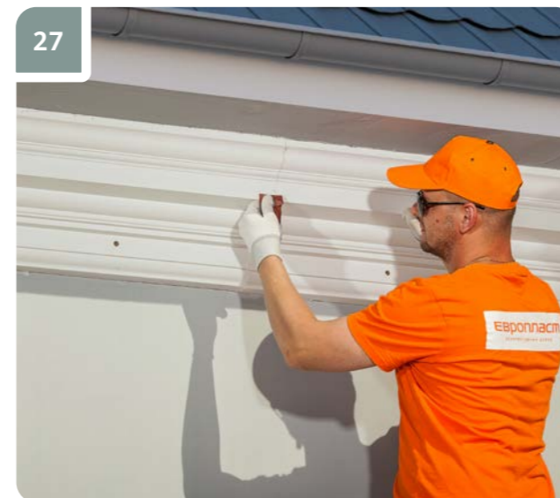
Спустя 3 часа мелкозернистой наждачной бумагой обработать стыки до получения ровной поверхности.
